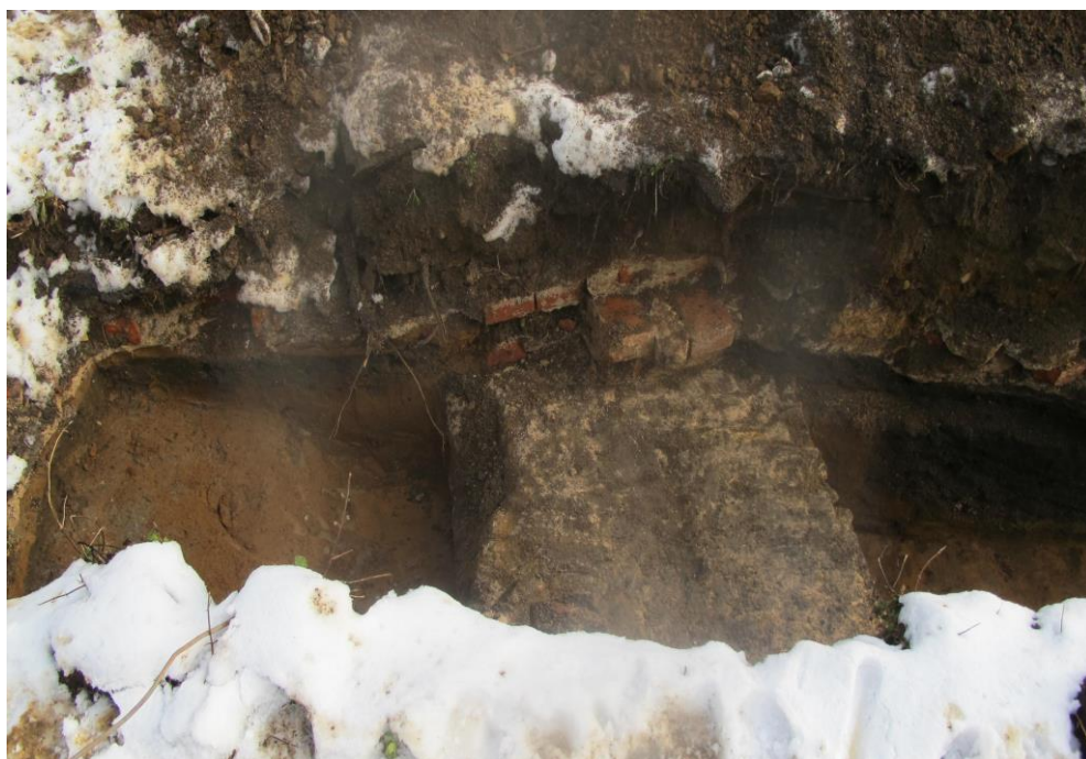
Obr. 44: 1 – Sonda 9. Severní okraj východního dokumentovaného řezu S9-RV se stavební konstrukcí recentní cihlové jámy č.s.j. 9021 (vpravo). Pohled od západu. Foto Marek Kamysz, únor 2019.
