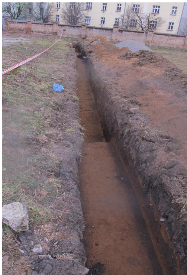
Obr. 34: 2 – Sonda 3. Severní část zjišťovacího bagrovaného řezu – sondy se zajištěným povrchem holocenní půdy č.s.j. 3020. Pohled od jihu. Foto Jan Poledne, únor 2019.
