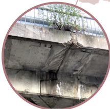
Modernizovaný úsek 02, dálniční nadjezd EXIT 21 Mirošovice ev. č. DN1-029
