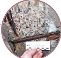
Modernizovaný úsek 16, dálniční nadjezd EXIT 119 Velký Beranov ev. č. DN1-161.1
