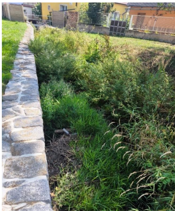
Foto č. 2: Stav projektu zjištěný kontrolou NKÚ
