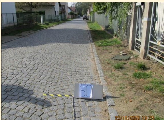
Fotodokumentace původního stavu
